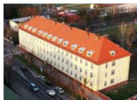
Oława Termomodernizacja Zespołu Szkół im. Zjednoczonej Europy
