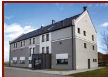
Rudyszwałd Budowa Ośrodka Integracji i Aktywności Społecznej
