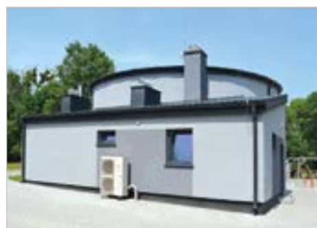
Mrągowo Główna przepompownia ścieków dla miasta Mrągowo
