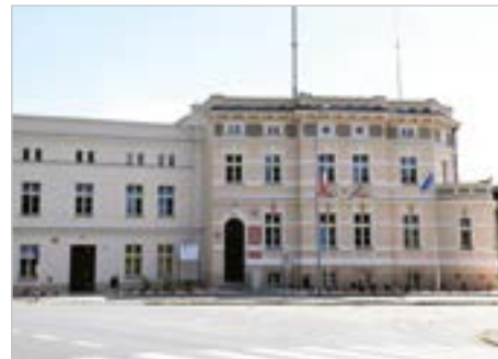
Bierutów Remont budynku Urzędu Miejskiego
