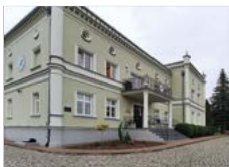
Elbląg Budynek biurowy Nadleśnictwa Elbląg
