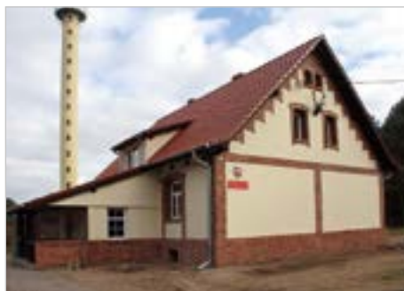
Chudaczewko - Postomino Remont i przebudowa Leśniczówki Chudaczewko
