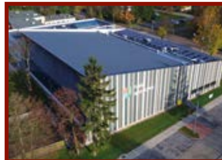
Cedry Wielkie Budowa Hali sportowo-widowiskowej
