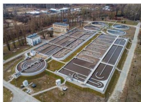
Grodzisk Mazowiecki Modernizacja części biologicznej oczyszczalni ścieków w zakresie budowy reaktora biologicznego, przebudowy istniejących reaktorów biologicznych ul. Chrzanowska 2
