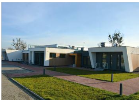
Łysomice Budowa Samodzielnego Publicznego Zakładu Opieki Zdrowotnej ul. Łąkowa 3
