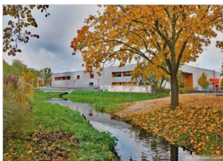
Błonie Budowa Centrum Sportu ul. Grodziska 1
