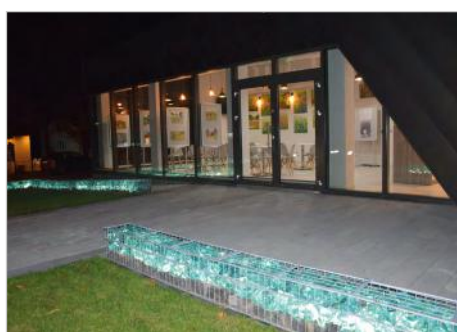
Gołcza Budowa Centrum Kultury, Gołcza 69
