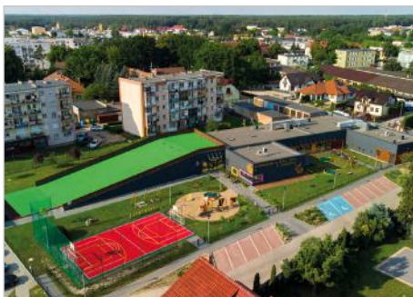
Międzychód Budowa Przedszkola Publicznego nr 3 im. Jana Brzechwy ul. św. Jana Pawła II/27
