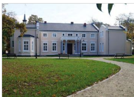
Granowo Rewitalizacja i termomodernizacja budynku Gminnego Ośrodka Kultury ul. Stawowa 1A
