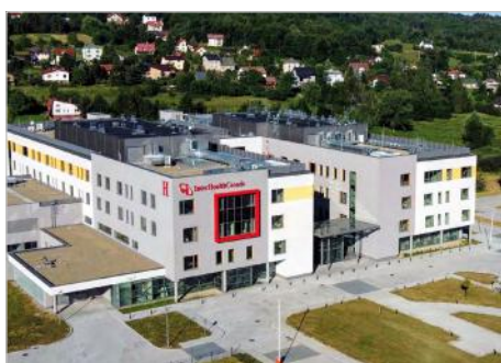
Żywiec Budowa Szpitala Powiatowego
