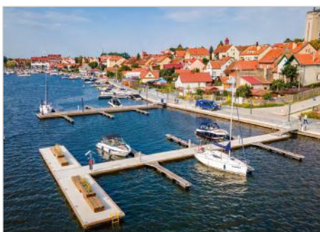
Mikołajki Budowa nabrzeża nad Jeziorem Mikołajskim Aleja Kasztanowa
