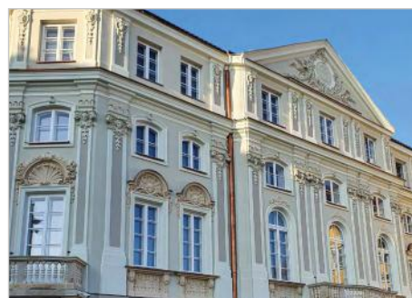
Warszawa Remont elewacji budynku Prokuratury Regionalnej ul. Krakowskie Przedmieście 25/1
