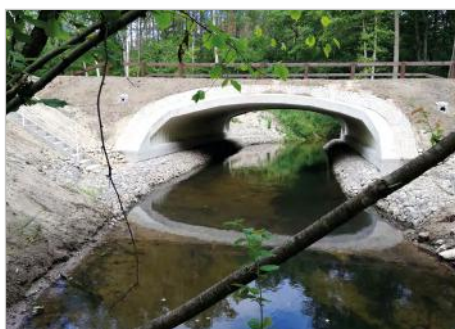
Bralin Przebudowa mostu drewnianego na rzece Korytnicy
