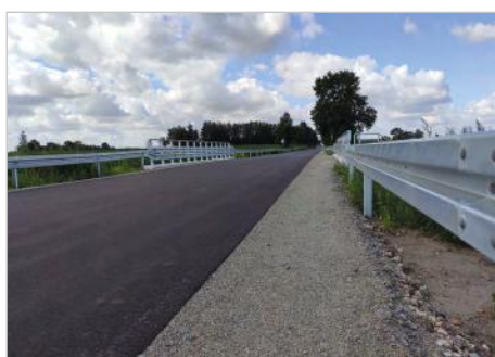
Szumanie-Bielsk Rozbudowa i przebudowa drogi powiatowej nr 3759W Szumanie-Bielsk
