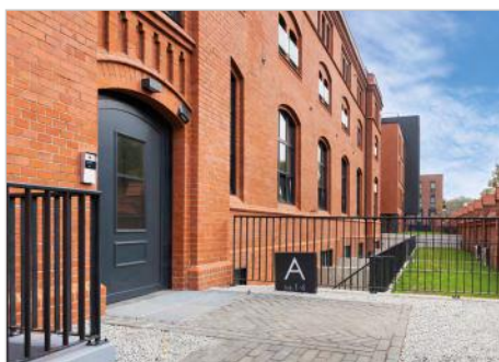
Toruń Grand Bulvar: Remont, przebudowa i nadbudowa budynku pralni garnizonowej na budynek mieszkalny ul. Wola Zamkowa 14, Św. Jakuba 14, Poniatowskiego 12
