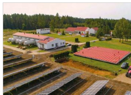
Przekopka Wewnętrzna instalacja fotowoltaiczna zasilająca Stację Uzdatniania Wody miasta Elk ul. Suwalska 73
