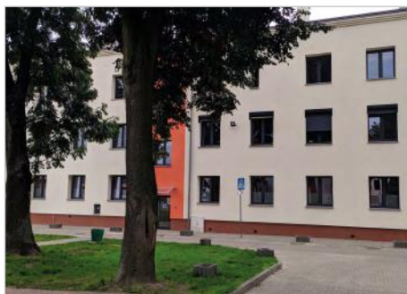
Aleksandrów Kujawski Termomodernizacja budynków D, K, L Powiatowego Szpitala i wymiana źródeł energii ul. Słowackiego 18
