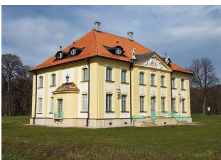
Choroszcz Modernizacja elewacji Pałacu Branickich - siedziby Muzeum Wnętrz Pałacowych w Choroszczy Oddziału Muzeum Podlaskiego w Białymstoku, ul. Pałacowa 2
