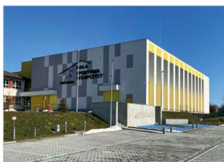
Łapczyca Budowa Hali Sportowej, Łapczyca 437
