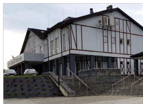
Niebochowy Budowa infrastruktury gminnej na terenie nowej wsi Niebochowy
