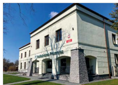
Przasnysz Przebudowa i nadbudowa budynku biurowego Nadleśnictwa Przasnysz ul. Zawodzie 4
