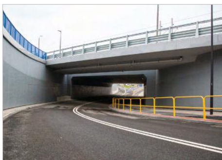
Wejherowo Budowa tunelu na Węźle Wejherowo-Kwiatowa
