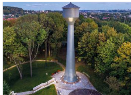
Będzin Nitowana wieża ciśnień Będzin-Grodziec ul. Willowa
