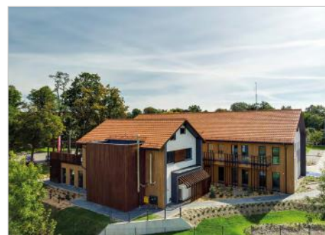
Oleśnica Śląska Budowa budynku biurowego Nadleśnictwa Oleśnica Śląska ul. Spacerowa 6
