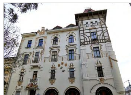
Bielsko-Biała Remont kamienicy przy ulicy Targowej 2 "Kamienica pod Żabami"
