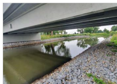
Podbolesławiec Przebudowa mostu drogowego nad rzeką Prosną droga powiatowa nr 4510E
