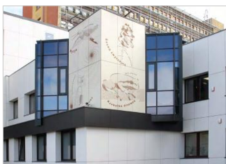
Ożarów Mazowiecki Termomodernizacja budynków Starostwa Powiatu Warszawskiego Zachodniego wraz z montażem OZE ul. Poznańska 129/133
