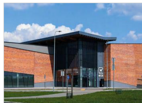
Brześć Kujawski Budowa obiektu wielofunkcyjnego: kultura, historia, bezpieczeństwo publiczne ul. Kolejowa 44
