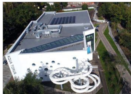
Toruń Rozbudowa i modernizacja Basenu Miejskiego ul. Bażyńskich 9/17
