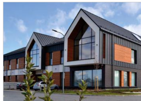
Międzyrzec Podlaski Budowa nowej Siedziby Nadleśnictwa Międzyrzec ul. Leśna 8
