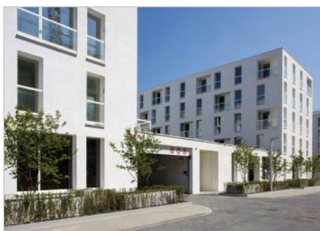
Warszawa Apartamentowiec ul. Bobrowiecka 10
