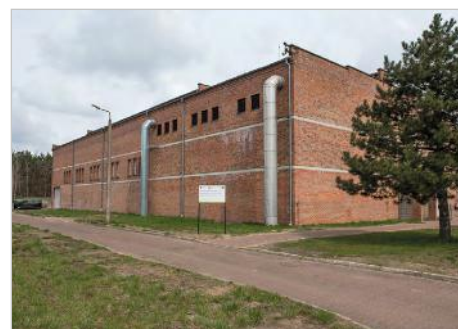
Ostrów Wielkopolski Modernizacja Stacji Uzdatniania Wody ul. Wodociąg Miejskie
