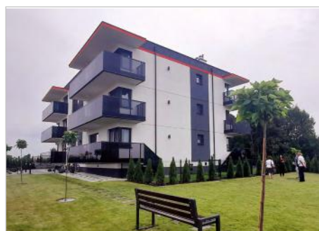
Inowrocław Budowa budynku mieszkalnego wielorodzinnego ul. Rzepakowa 28
