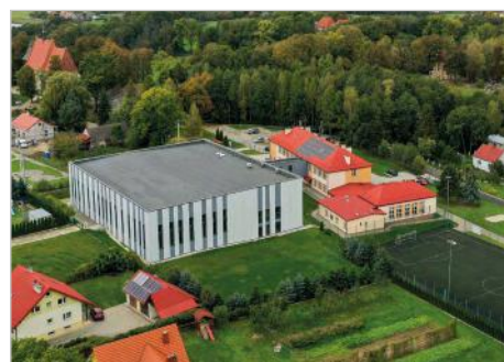
Dębno Budowa Hali Widowiskowo Sportowej, Dębno 212
