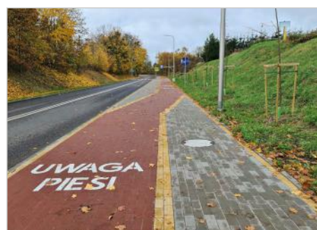
Lidzbark Warmiński Przebudowa ul. Dąbrowskiego
