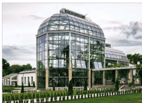
Kraków Przebudowa i rozbudowa szklarni Viktoria w Ogrodzie Botanicznym Uniwersytetu Jagiellońskiego ul. Kopernika 27
