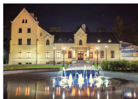
Siemianowice Śląskie Rewitalizacja zdegradowanego budynku Pałacu Rheinbabenów ul. Oświęcimska 1
