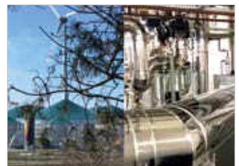
Potęgowo Ekologiczny ciepłociąg gminny z biogazowni Gmina Potęgowo
