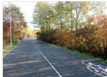
Rzeszów Poszerzenie ciągu pieszo-rowerowego nad zalewem rzeki Wisłok od Lisiej Góry do ul. Jarowej
