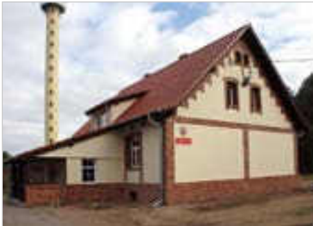
Chudaczewko - Postomino Remont i przebudowa Leśniczówki Chudaczewko
