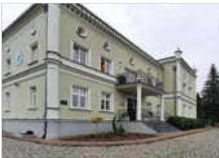
Elbląg Budynek biurowy Nadleśnictwa Elbląg
