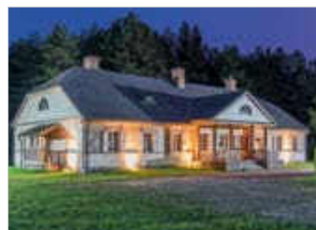
Bobry Wielkie - Wasilków Remont dworu z Bobry Wielkiej wraz z zagospodarowaniem wnętrza na terenie Podlaskiego Muzeum Kultury Ludowej
