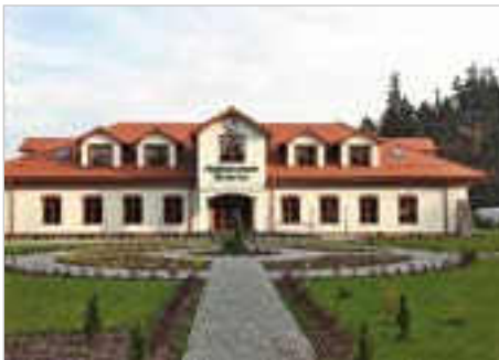
Damnica Budowa budynku biurowego wraz z infrastrukturą towarzyszącą Nadleśnictwa Damnica
