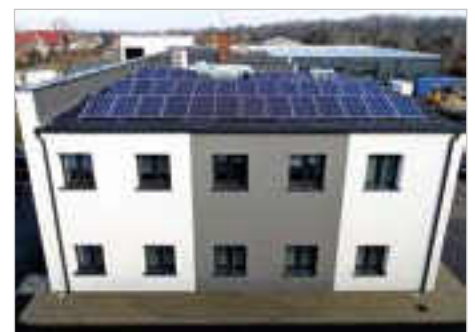
Ostrów Wielkopolski Termomodernizacja budynku administracyjno-socjalnego Rejonu Dróg Wojewódzkich
