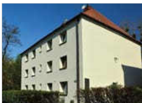
Bytom Termomodernizacja Budynku Mieszkalnego Wielorodzinnego ul. Prusa 8 i Kossaka 13, 15
