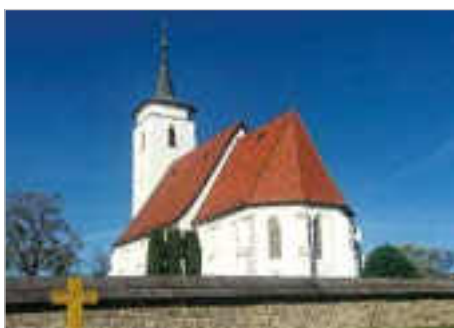
Stary Bielsk - Bielsko Biała Remont elewacji Kościoła Św. Stanisława Męczennika
