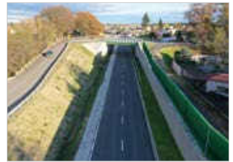
Oborniki Zmiana przebiegu drogi wojewódzkiej nr 178 w Obornikach. Wykorzystanie przestrzeni kolejowej na infrastrukturę drogową.
