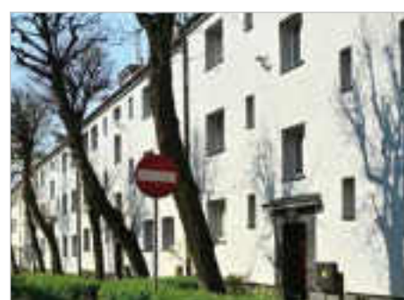
Bytom Termomodernizacja Budynku Mieszkalnego - Wielorodzinnego przy ulicy Kossaka 17, 19, 21
