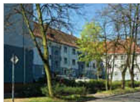
Bytom Termomodernizacja Budynku Mieszkalnego - Wielorodzinnego przy ulicy Pułaskiego 55-67
