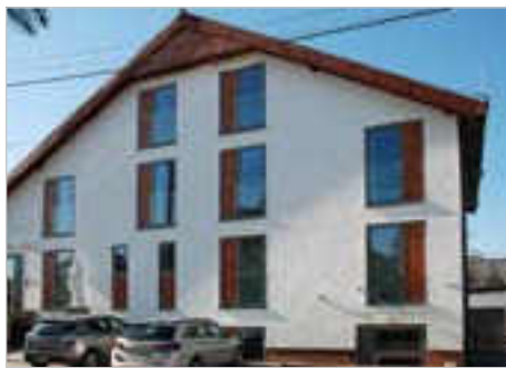
Olsztyn Dom misyjny Zgromadzenia Księża Najświętszego Serca Jezusowego (Księża Sercanie) ul. Rakowa 11
