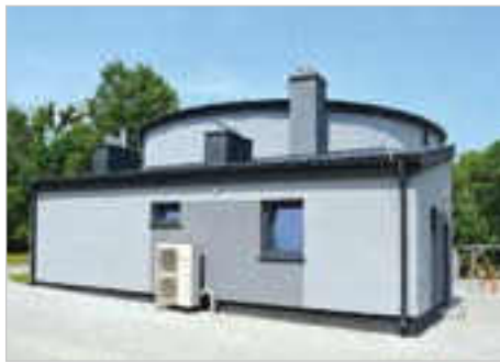
Mrągowo Główna przepompownia ścieków dla miasta Mrągowo
