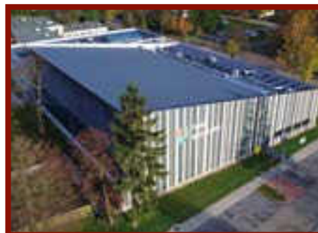
Cedry Wielkie Budowa Hali sportowo-widowiskowej
