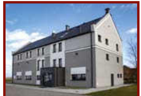
Rudyszwałd Budowa Ośrodka Integracji i Aktywności Społecznej
