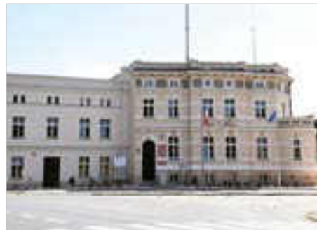
Bierutów Remont budynku Urzędu Miejskiego
