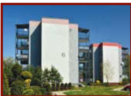
Bytom Modernizacja budynku mieszkalnego - dobudowa balkonów przy ulicy Hlonda 4 i 6
