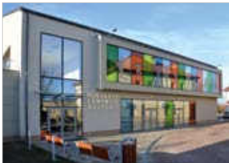
Radłów Rozbudowa, nadbudowa i przebudowa istniejącego budynku synagogi wraz ze zmianą sposobu użytkowania na Miejskie Centrum Kultury z niezbędną infrastrukturą techniczną
