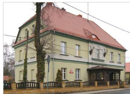
Prószków Modernizacja i rozbudowa budynków Nadleśnictwa Prószków wraz z zagospodarowaniem terenu ul. Opolska 11
