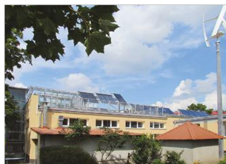
Wyszków Modernizacja Mazowieckiego Edukacyjnego Centrum Energii Odnawialnej przy Liceum Ogólnokształcącym im. C.K. Norwida ul. 11 listopada 1
