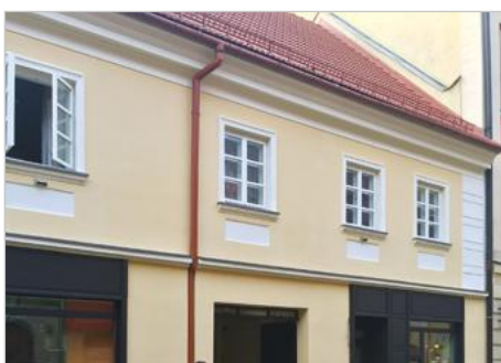
Bielsko-Biała Renowacja zabytkowego budynku mieszkalnego ul. 11 listopada 64
