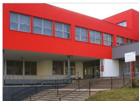
Bielsko-Biała Termomodernizacja budynku wraz z montażem kolektorów Słonecznych w Zespole Szkół Ogólnokształcących im. Armii Krajowej ul. Sternicza 4
