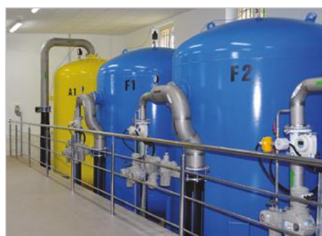
Bolesławiec Modernizacja ujęcia i Stacji Uzdatniania Wody „SUW Rakowice”
